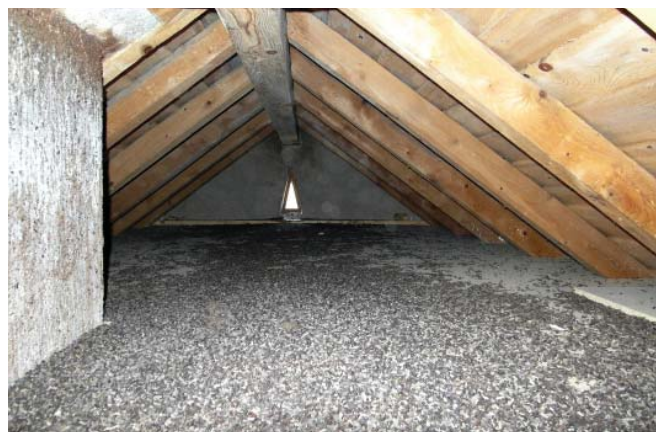
Le maintien d'un petit surcomble froid permet aux chauves-souris de rester sous les toits malgré les fortes chaleurs estivales
