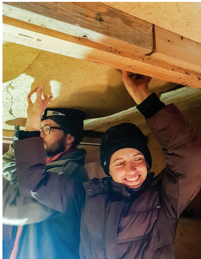
Travaux d'isolation en faveur d'une colonie de Petits Rhinolophes.
